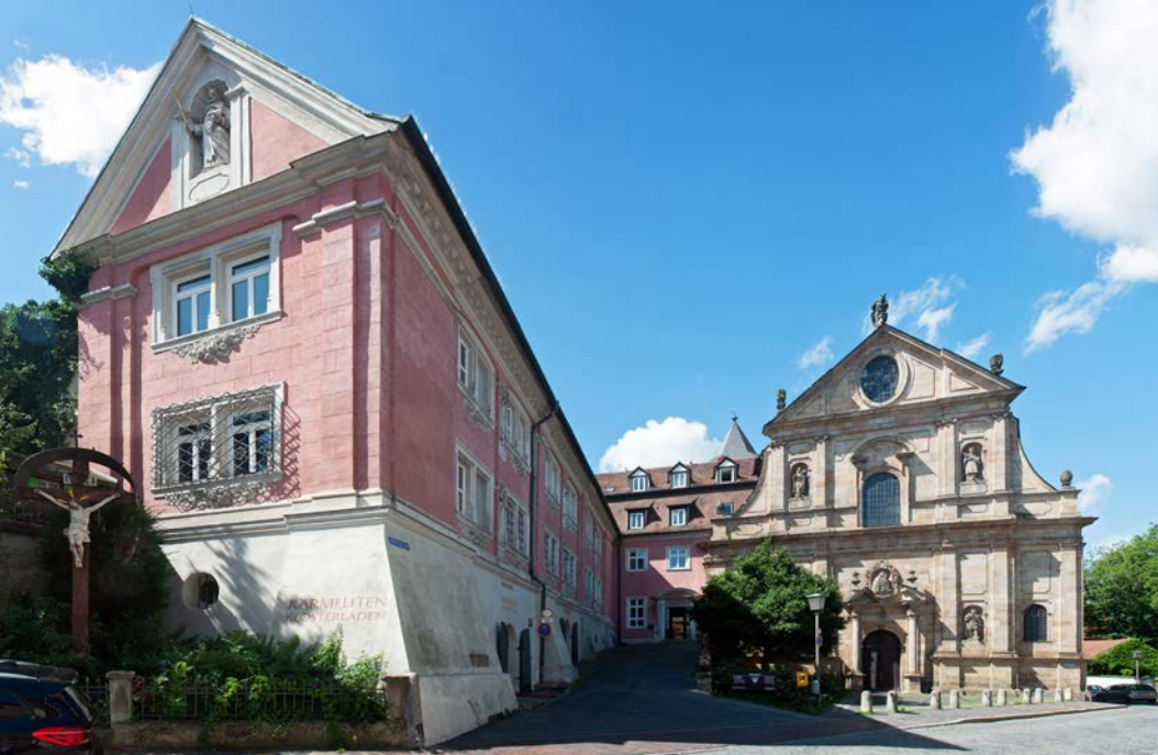
Die Kirche St. Maria und St. Theodor (rechts im Bild) in Ihrer Nachbarschaft am Karmelitenplatz bietet Raum für Gebete und Gottesdienste. Eine Sanierung ist geplant.
